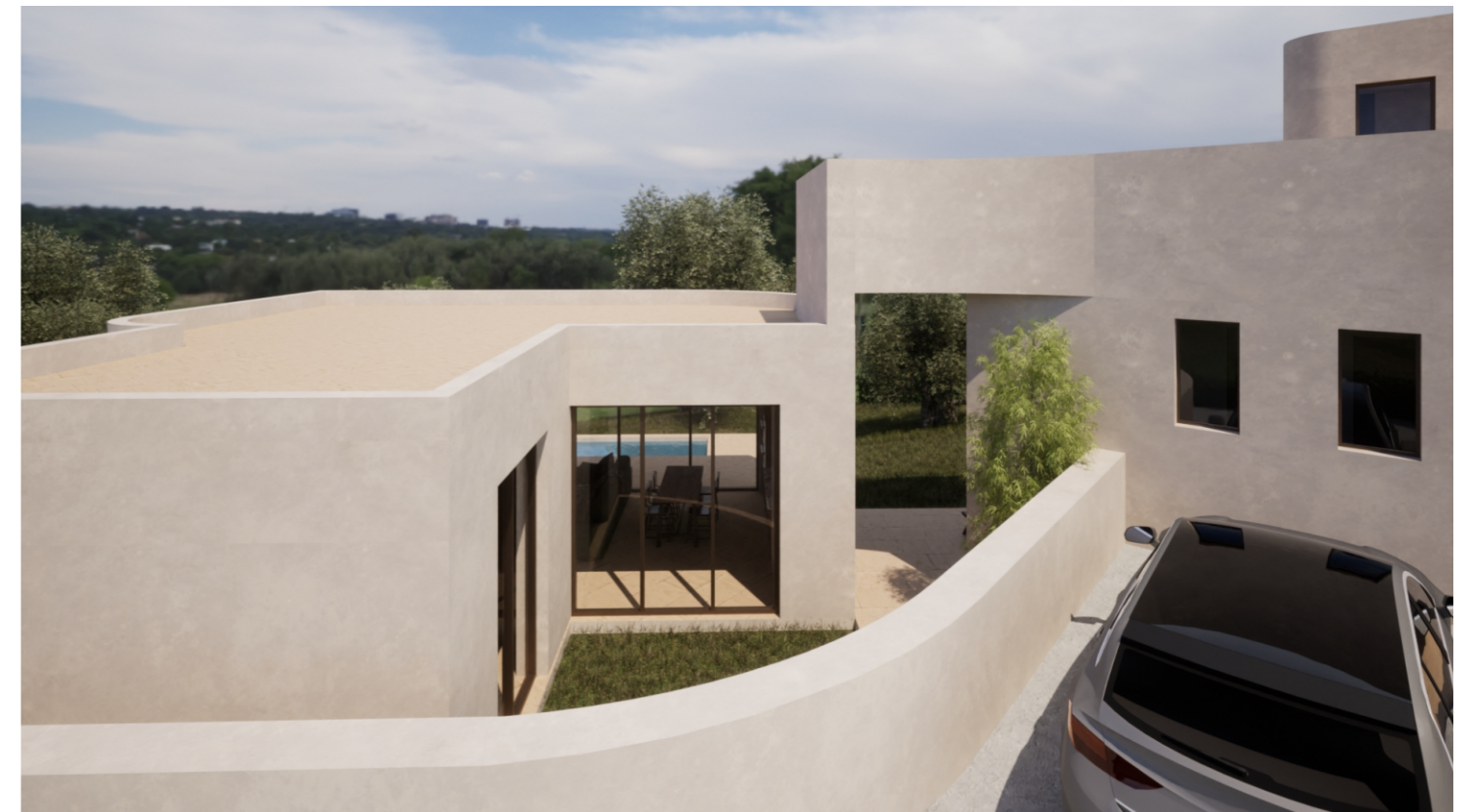
Vista patio sur y acceso hall común
